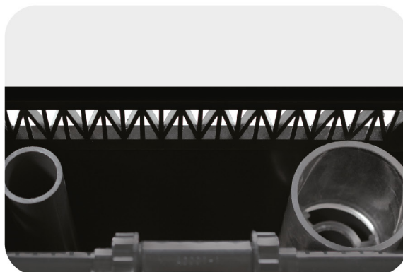
Overflow / Descente d'eau.
